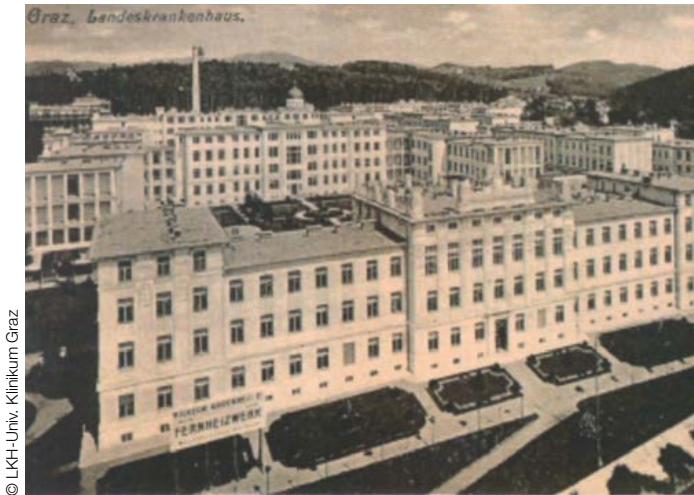
Über den heute zugemauerten Vordereingang erreichbar, lagen die beiden Zimmer des evangelischen Betraums unmittelbar rechts daneben
