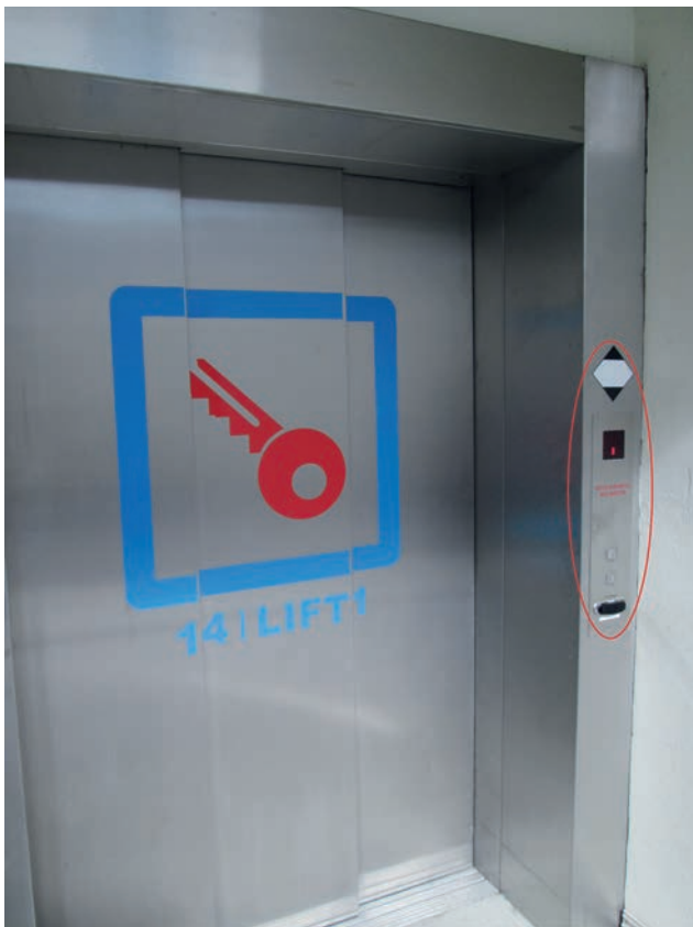
Transportaufzug für gefährliche Arbeitsstoffe mit entsprechender Kennzeichnung und technischer Ausstattung
