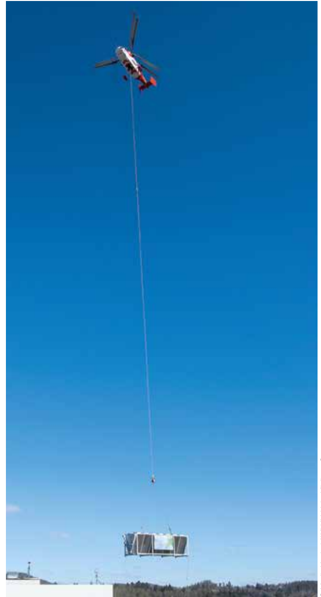
Der Schwerlasten-Hubschrauber „Kamov KA 32“ überstellte die Rückkühler der Kältemaschinen vom Dach des alten B-Trakts des Chirurgiekomplexes auf jenes des neuen C-Trakts
