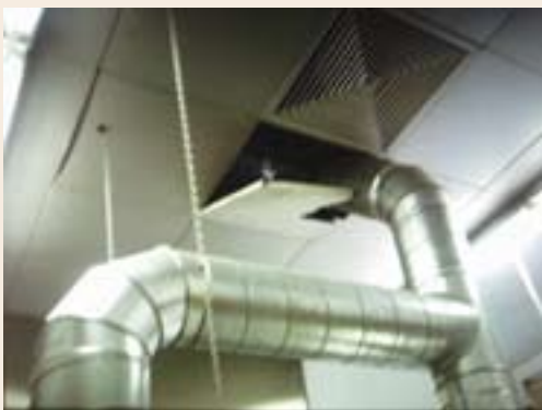
Loses Zwischendeckenelement
