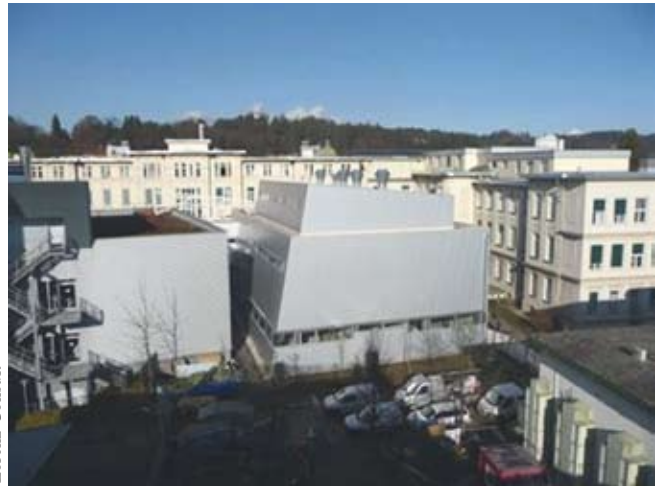
Das neue OPZ-C im Innenhof der Chirurgie.
