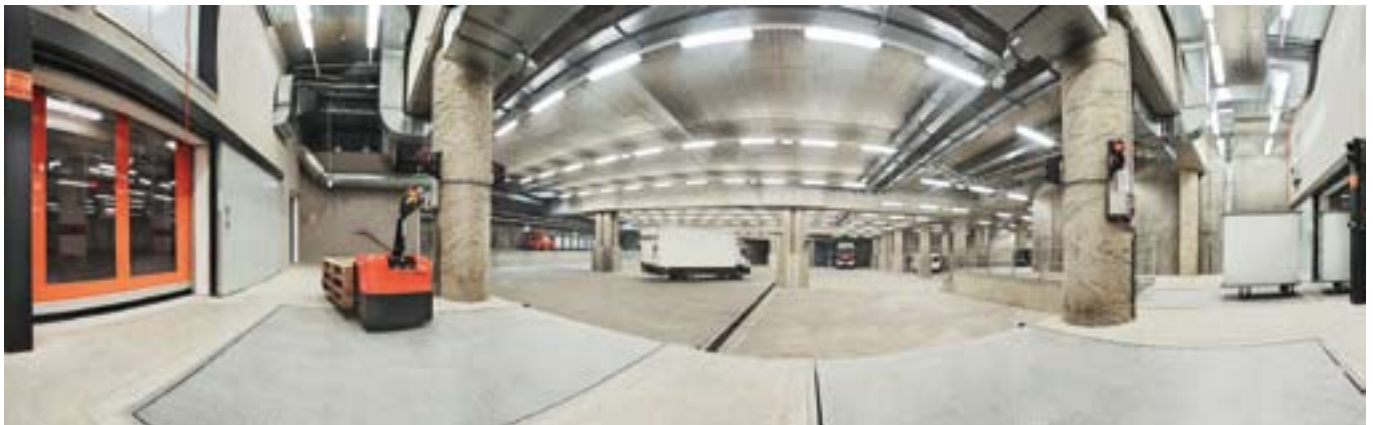
Dreh- und Angelpunkt ist der großräumige Übergabebahnhof.
