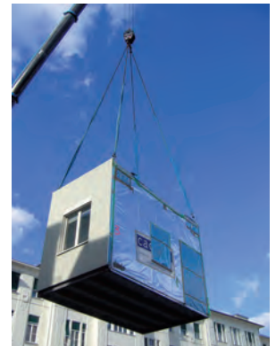
Die Container werden mittels Kran aus dem Innenhof abtransportiert.
