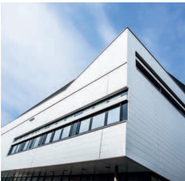
Im ersten Stock befindet sich die neue Küche
