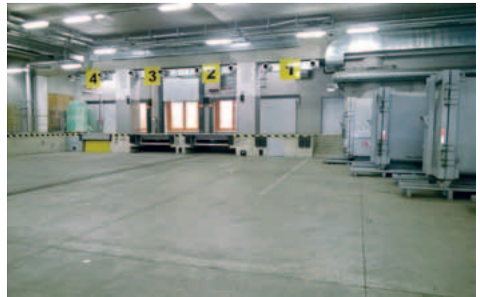
Tunnelübergabebahnhof („Tor zum Logistiktunnel“)
