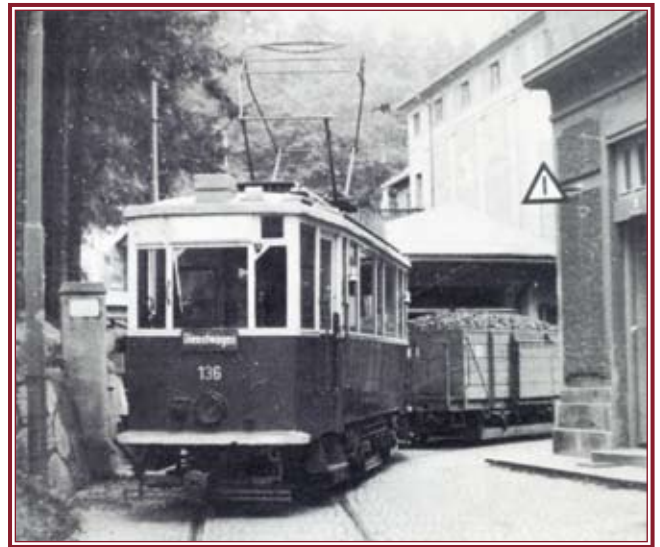
... und biegt vor dem Kesselhaus um die Ecke (1956). – Aus: Hans Sternhart, Straßenbahn in Graz (Wien 1979) 167.
