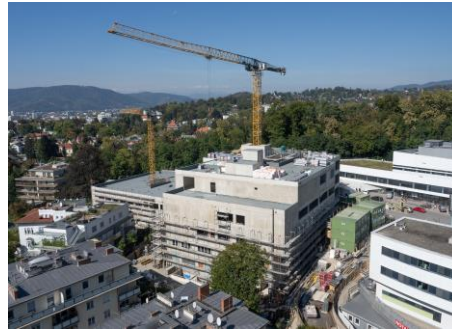
Rohbau der Radiologie NEU am Uniklinikum Graz
