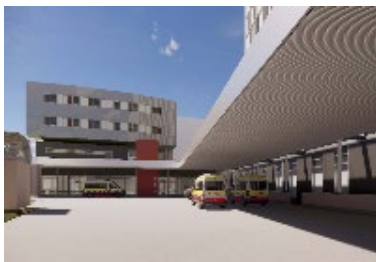
Bauetappe 3/ZNA Vorplatz
